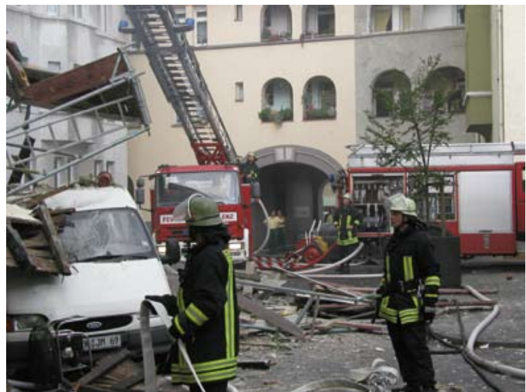
Schwierige Positionierung der Fahrzeuge aufgrund enger Durchfahrt
