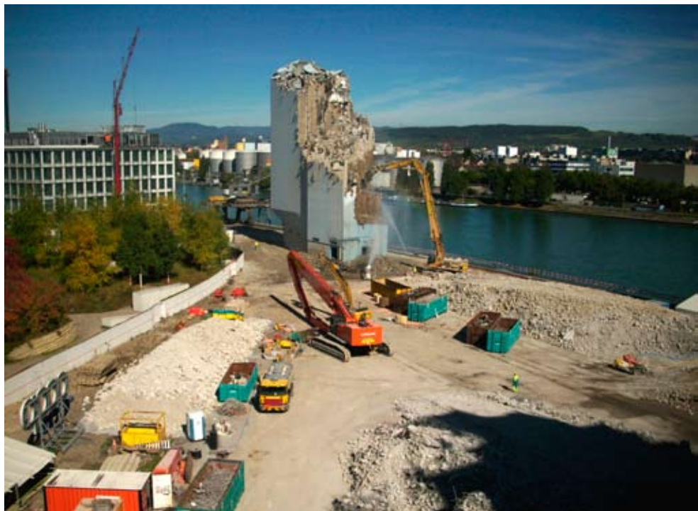
Rückbau eines Silobäudes im Hafen St. Johann (Bild: Ecosafe Gunzenhauser AG)
